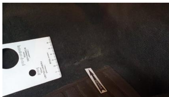
Fot. 46 Wykładzina podłogi (Pęknięcie/Rozerwanie)
