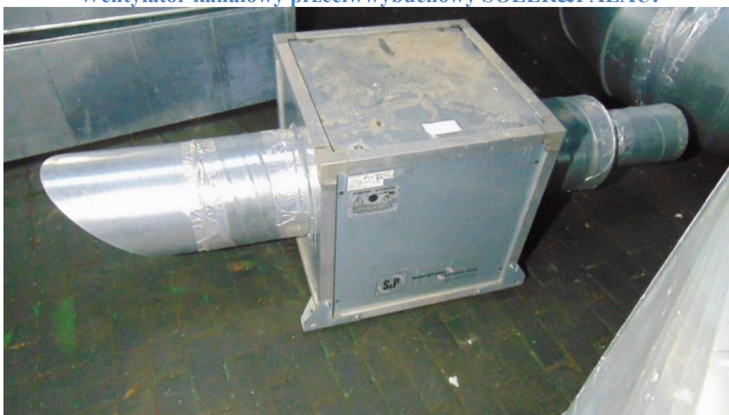
Wentylator kanałowy przeciwybuchowy SOLER&PALAU:
