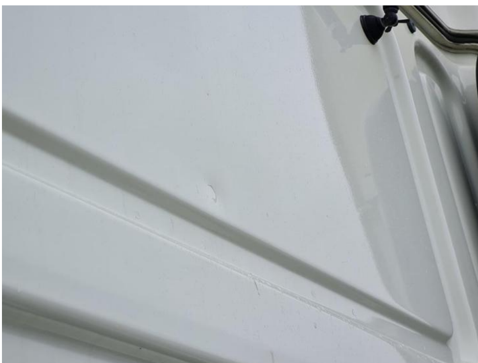
Fot. 46. ściana tylna
