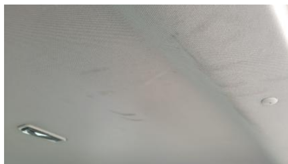
Fot. 38 Podsufitka - Inne 1
