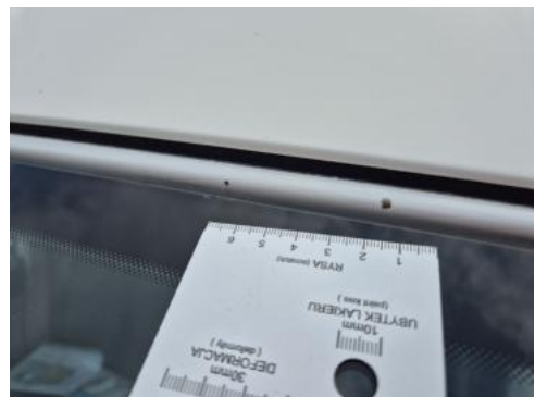
Fot. 38 Dach - Inne 2
